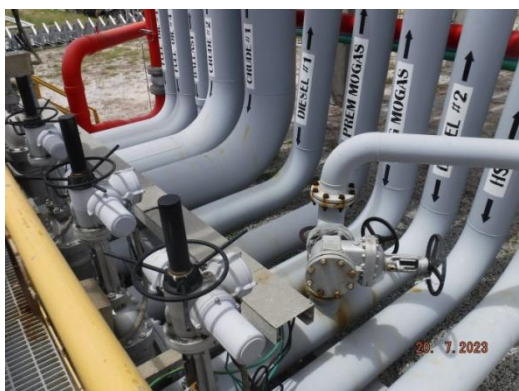
รูปที่ 3-2 ระบบหยุดปฏิบัติการฉุกเฉิน (Shore Line Block Valve)
