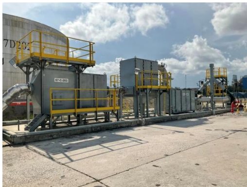
รูปที่ 3-5 ระบบควบคุมไอระเหยจากท่อระบายของถังเก็บก๊าซหุงต้ม
