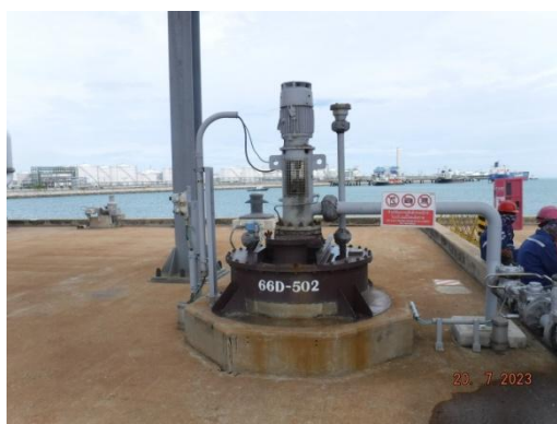
รูปที่ 3-9 บ่อพักน้ำ (Oily Water Tank)
